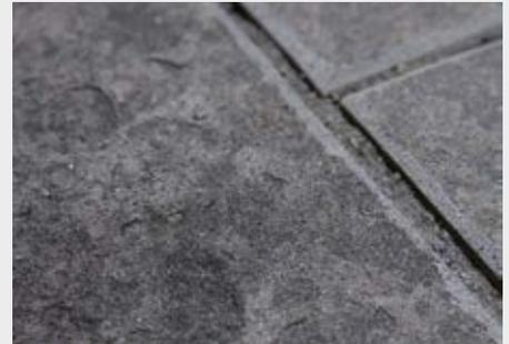
feinkörnigen Grundmasse. Bei einigen Basaltvarianten können jedoch gröbere, mit bloßem Auge zu erkennende Einsprenglinge vorkommen. Das Gestein ist sehr hart und unempfindlich gegenüber äußerem Einfluss, Frost und mechanischer Beanspruchung. Basalt lässt sich sehr gut sägen, polieren, schleifen und bürsten und wird aufgrund dieser positiven Eigenschaften gerne als Baustoff verwendet.
