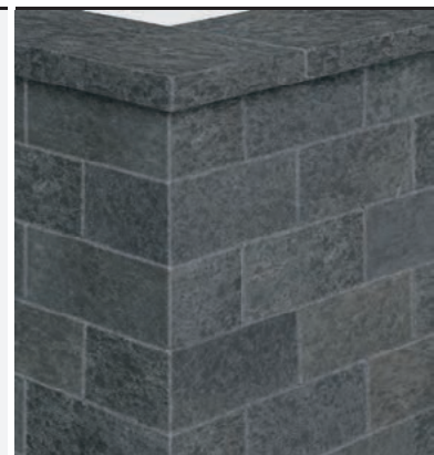
Sichtköpfe beim Einbau nachgearbeitet.
