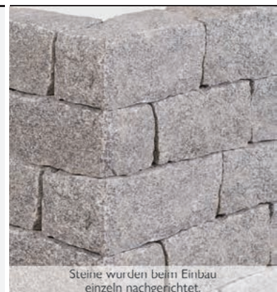
Sichtköpfe beim Einbau nachgearbeitet.
