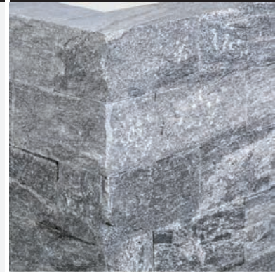
Sichtköpfe beim Einbau nachgearbeitet.
