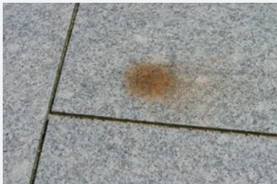
Eisenoxydanteil im Verlegesplitt
