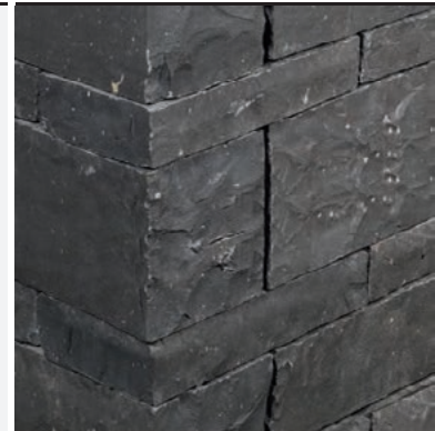
Sichtköpfe beim Einbau nachgearbeitet.
