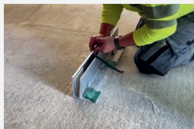
Gummilippe und Kunststoffschuhe einsetzen
