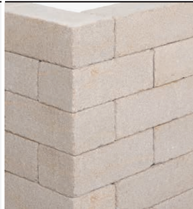
Sichtköpfe beim Einbau nachgearbeitet.
