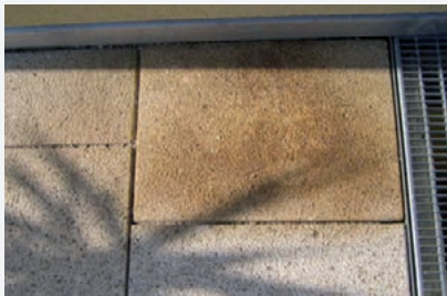
Eisenoxydanteil im Verlegesplitt
