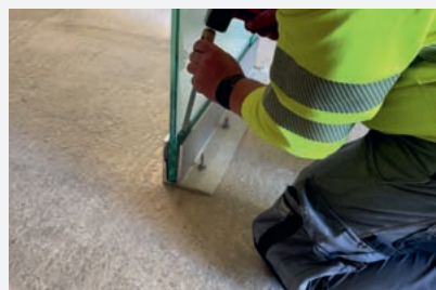
Kunststoff-Keile einschlagen und Gummilippe einsetzen.
