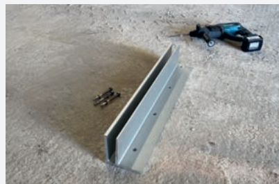
Löcher markieren und bohren
