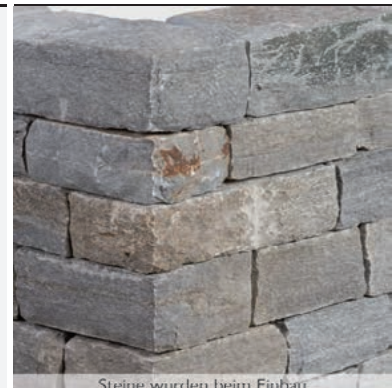
Steine wurden beim Einbau einzeln nachgerichtet.
