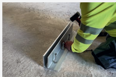
Anker einschlagen und festziehen
