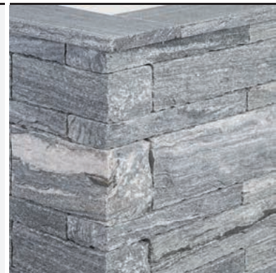
Sichtköpfe beim Einbau nachgearbeitet.
