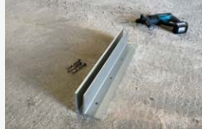
Löcher markieren und bohren
