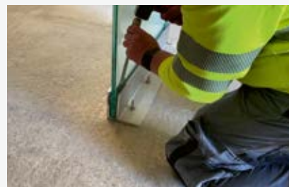
Kunststoff-Keile einschlagen und Gummilippe einsetzen.
