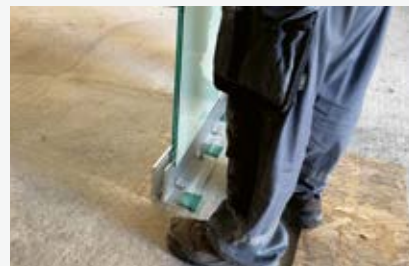
Sichtschutz-Element einsetzen
