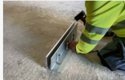
Anker einschlagen und festziehen
