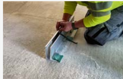
Gummilippe und Kunststoffschuhe einsetzen
