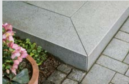
Gehrungsschnitte bei Blockstufen – ob Naturstein oder Keramik-Verbund-Produkte ...
